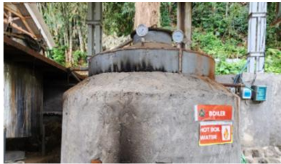
Gambar 5. Pemasangan Pressure Gauge
