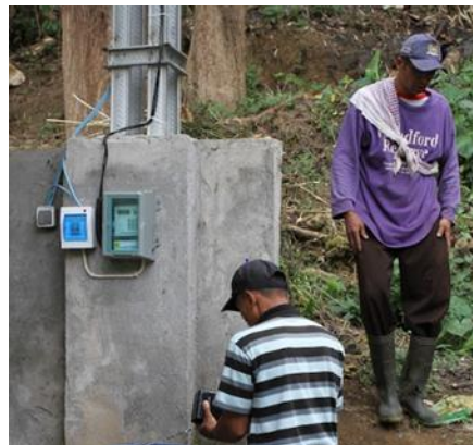
Gambar 4. Pemasangan Instalasi listrik
